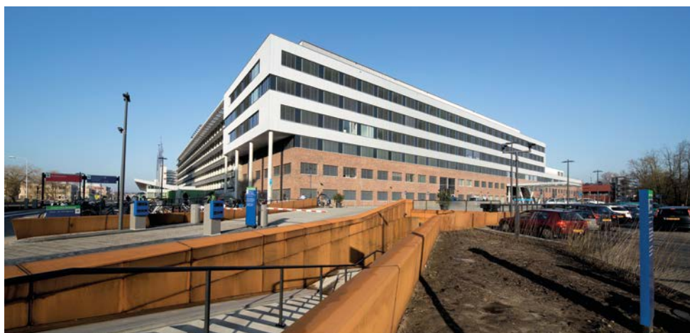
Entree fietsenkelder met cortenstaal afwerking.
