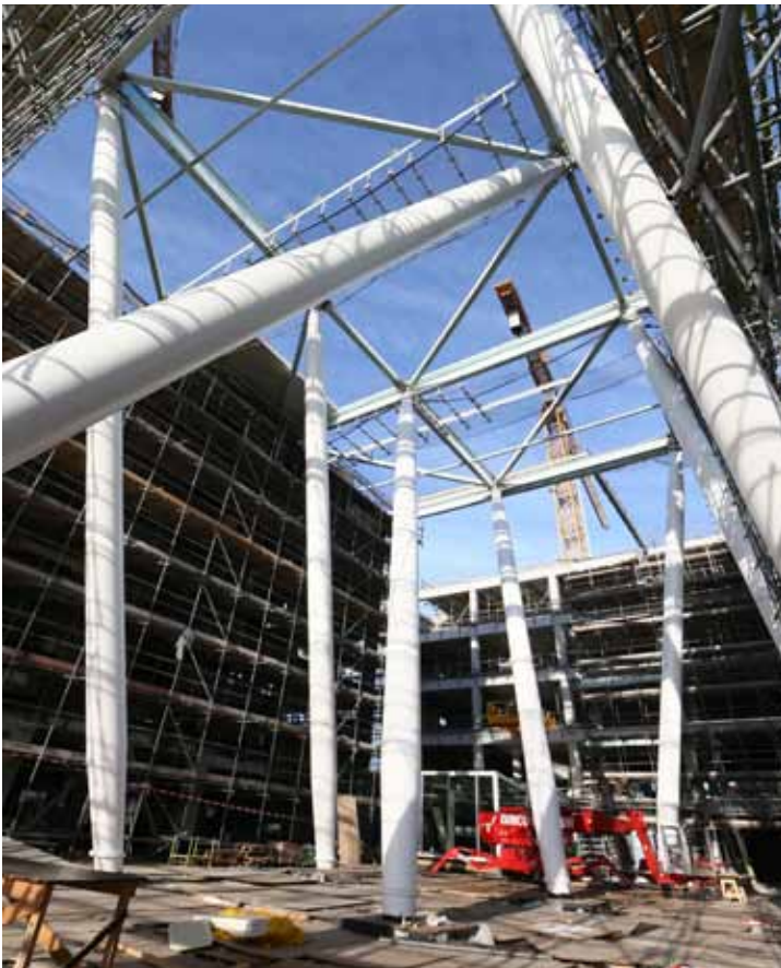
In de bouwvak werd gewerkt aan de plaatsing van tonnen zware kolommen
