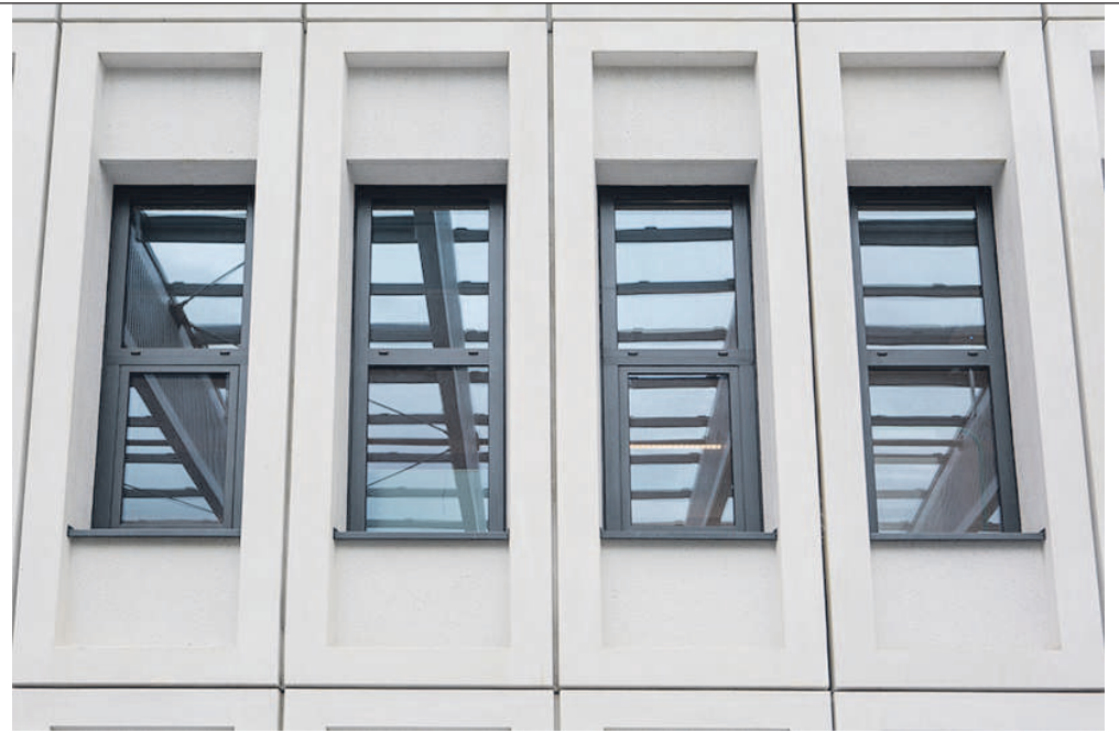
Het glazen dak van de passage, hier weerspiegeld in ramen, is de centrale lichtbron.
