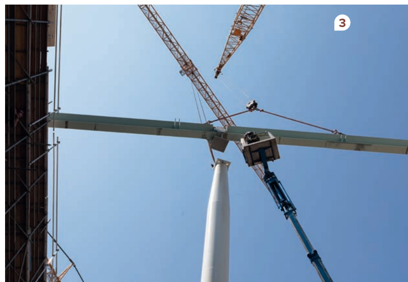
1 // Plaatsing van de mikado's gebeurde volgens een volledig uitgewerkt montageplan. Hier wordt een 20 meter lange mikadokolom opgeheven. 2 // De HEM 1000-ligger met de aansluitknopen voor de mikado's is tijdelijk ondersteund. 3 // Door een slimme inzet van materieel kon de inzet van hulpconstructies voor het ondersteunen van de mikado's beperkt blijven.
